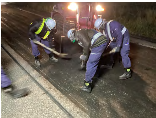
▲アスファルト舗装 切削基面 清掃状況(夜間) 切削基面の清掃を行い、舗装の品質を高めています。
