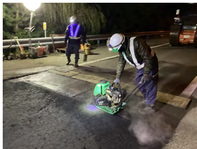
▲アスファルト舗装 締固め状況(夜間) 細部まで人力にて締固めを行い、品質を確保しています。
