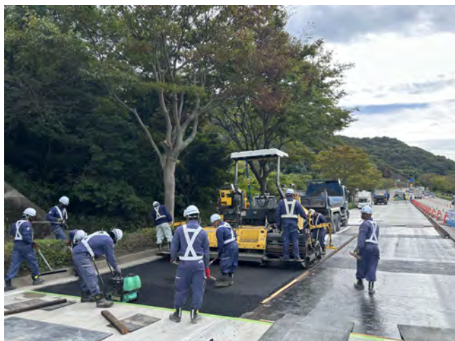
▲アスファルト舗装 舗設状況 道路通行規制を実施後、安全に作業を行います。
