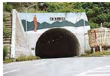
土釜トンネル整備工事
