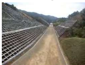
四国横断自動車道 替坂本工事 (高知県)
