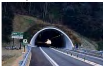
関柱トンネル工事 (北唱谷トンネル)
