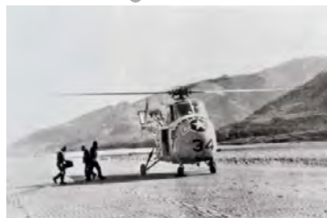
米軍機・仮設滑走路工事 (美馬町)
