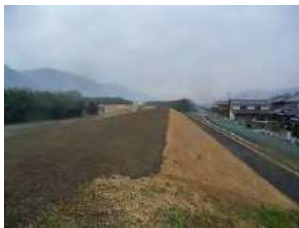
平成12年度 中島堤防工事
