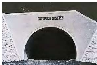
野田ノ井トンネル改良工事
