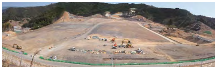
高知(17)新駐屯地造成土木工事(その1)
