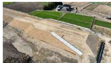
令和3-4年度 沼田堤防護岸 (その3) 外工事
