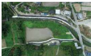
平成31年度 伊沢市堤防護岸工事
