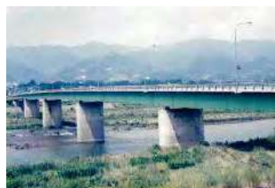
橋梁整備工事 (小島橋)
