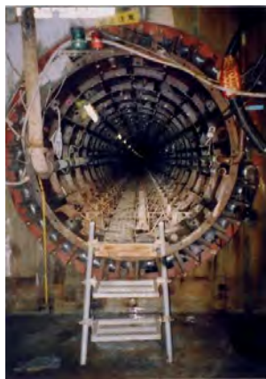
←旧吉野川流域下水道建設事業 旧吉野川幹線管渠工事 (北島町)
