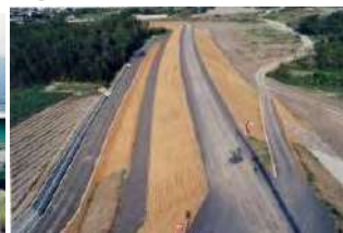
郡里堤防工事
