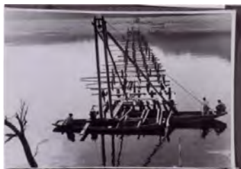
美馬町重清分谷口～半田町間の 潜水橋架設工事
