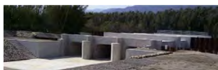
平成16年度 中島川樋門新設工
