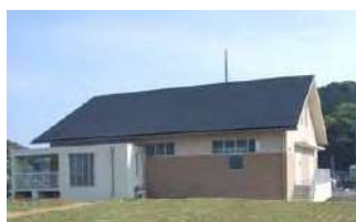
海部町海部浄化センター 建設工事
