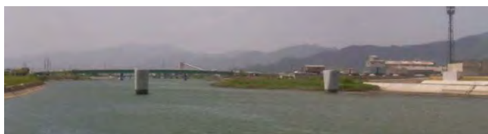
四国横断自動車道 長岸工事 (松茂町)
