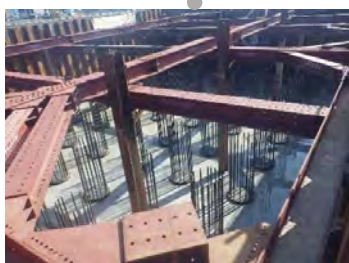
沖洲高架橋下部 (P18その2) 工事
