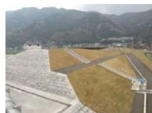
平成23-24年度 山口谷川 右岸堤防(その1)工事
