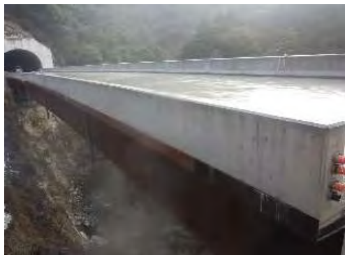
平成27年度 箸蔵第2橋床版外工事
