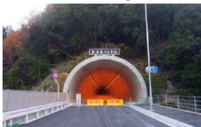
道路改築工事一般国道438号 (新府能トンネル)
