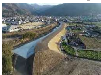
令和元年-2年度 加茂谷川堤防護岸外工事
