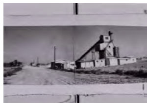
北島生コン工場 (北島町鯛ノ浜)
