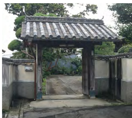
▲現存する稲田西屋敷の門 (脇町猪尻)
