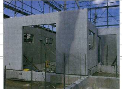
壁部材としての採用例。混和材を配合したことで耐塩害性が向上するので塩害対策措置の省力化が可能。構造物の長寿命化も見込める
